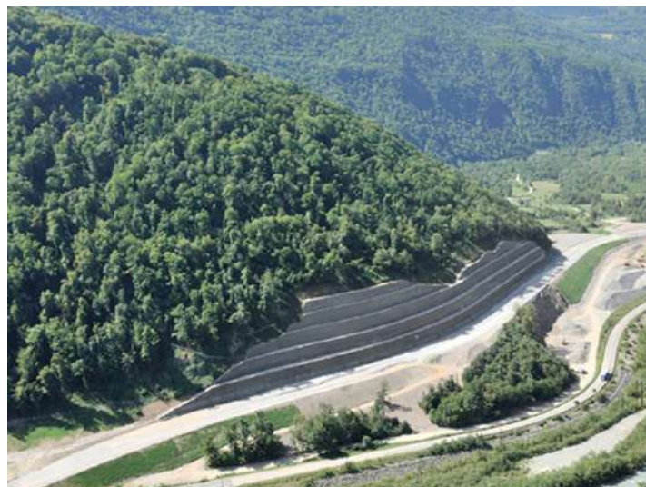
Figure 161 : Exemple de paroi clouée – déviation de Séchilienne- source NGE Corporate
