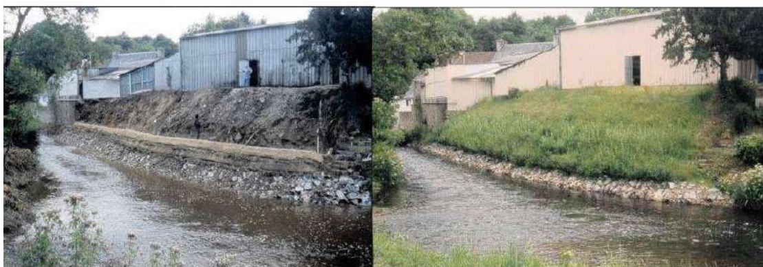
Figure 50. Exemple de chantier de restauration et stabilisation de berges au moyen de techniques mixtes : empierrement sous-fluvial et lits de plants et plançons renforcés par des boudins de géotextile. Etat de l'ouvrage en cours de chantier puis six mois après l'achèvement des travaux.
